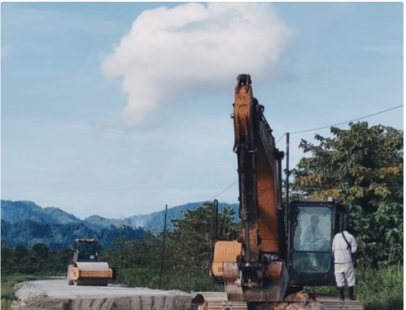
Tampak Alat Berat excavator sedang melakukan pengerjaan jalan Trans Bunta Morut Sulawesi Tengah
